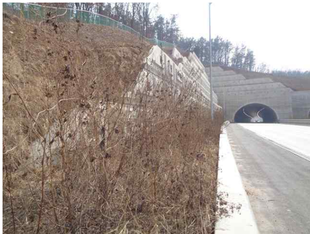
1공구 보강토옹벽(본선 STA.6+933~7+040)
