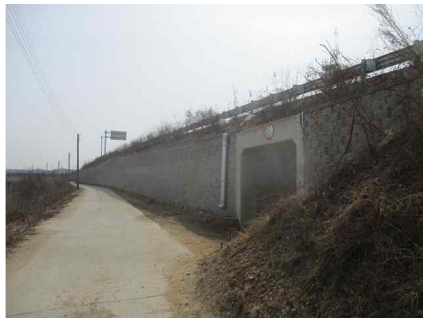
4공구 PRN옹벽 (STA.27+049~27+240)
